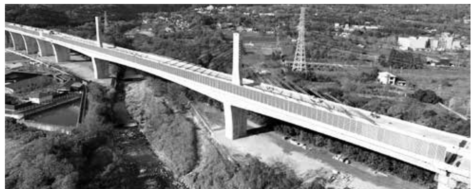
菰野第2高架橋
