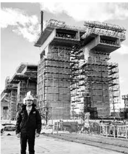
写真 3 張り出し架設工法
