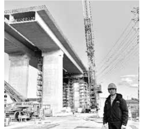
写真 4 スパンバイスパン工法
