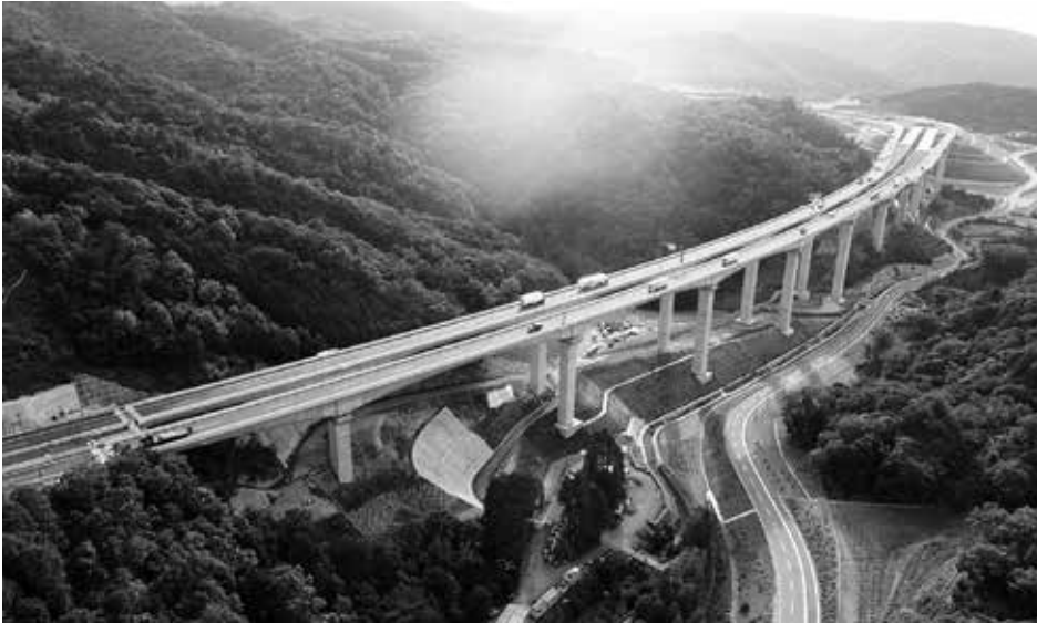
陽梅山高架橋
